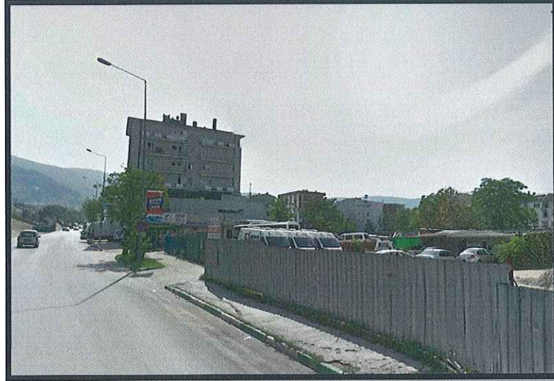
Alanın Ferruh Yücel Caddesi'ne bakan cephesi
