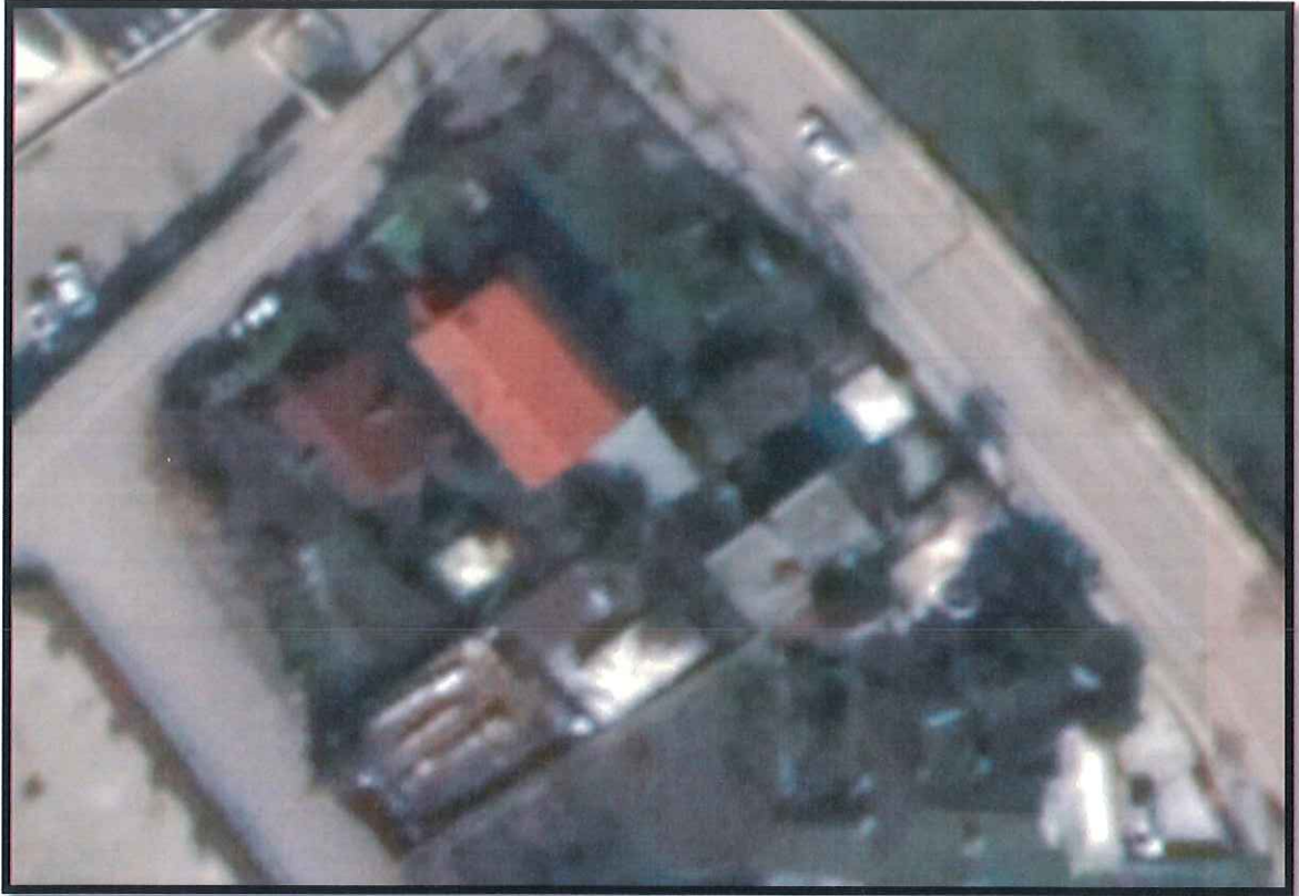
Parsellerin yapılaşma durumunun hava fotoğrafı
