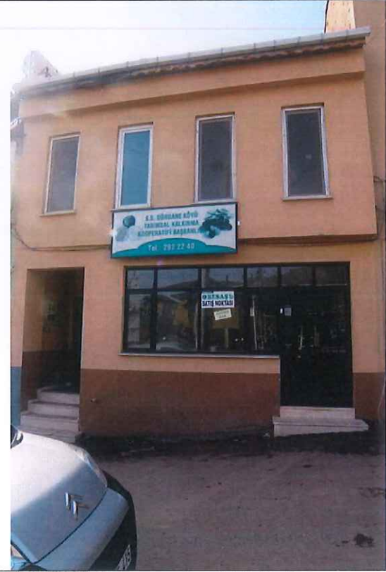
10040 ada 544 parsele ait fotoğraf
