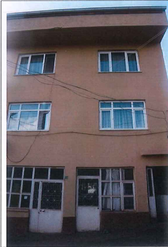
10040 ada 543 parsele ait fotoğraf
