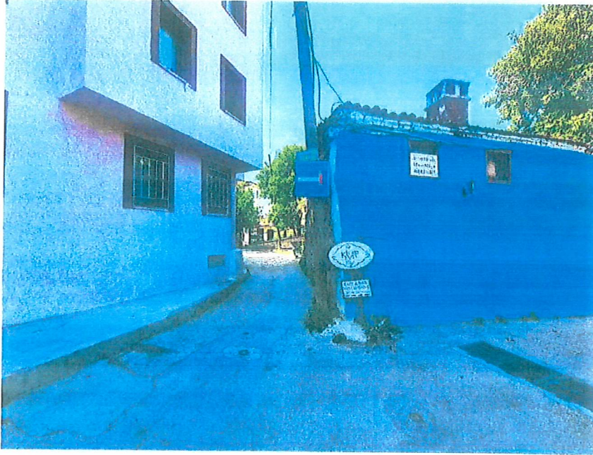
Yola terk edilmesi öngörülen bahçe ve müştemilat duvarı
