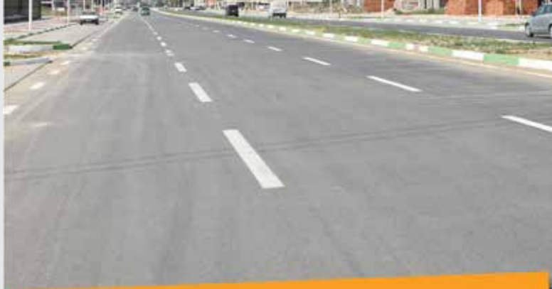
40 m'lik Bulvar YENİ BAĞLANTI YOLLARI, ULAŞIMI RAHATLATAÇAK Terminaiden gelen araçlar bağlantı yolu ile Mudanya Yolu'na ulaşacak
